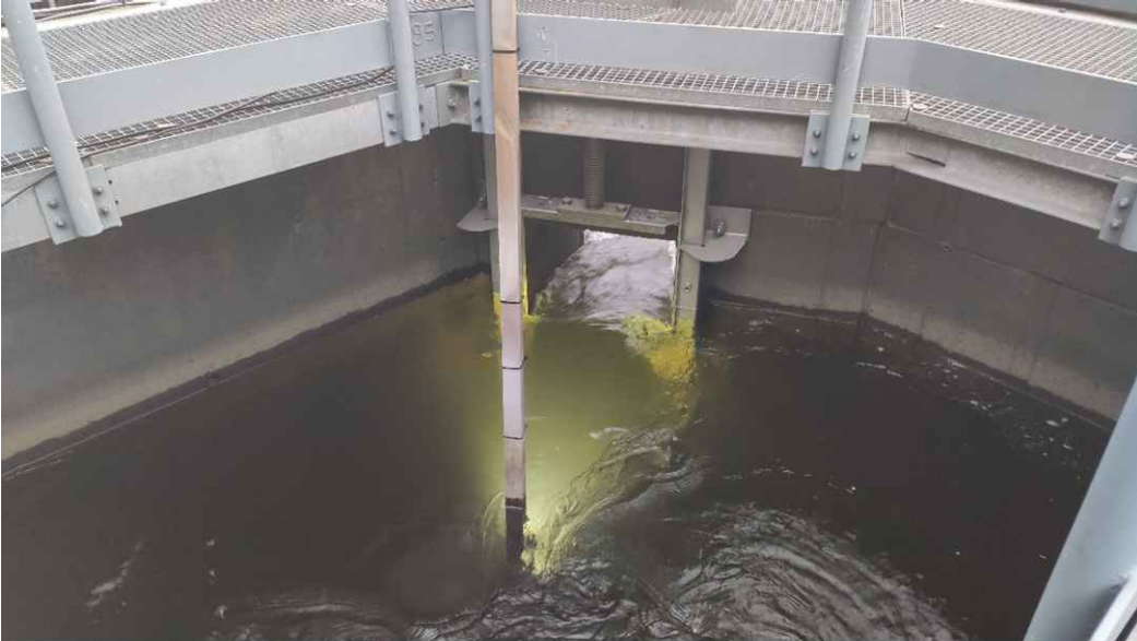
Kuva 6. Korkeakosken kalatien suulle asennettu houkutusvalo.
